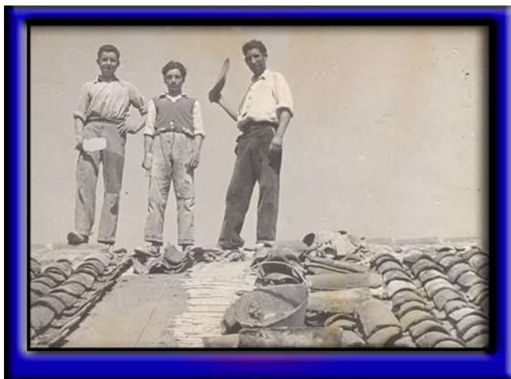
Albañiles en el tejado
