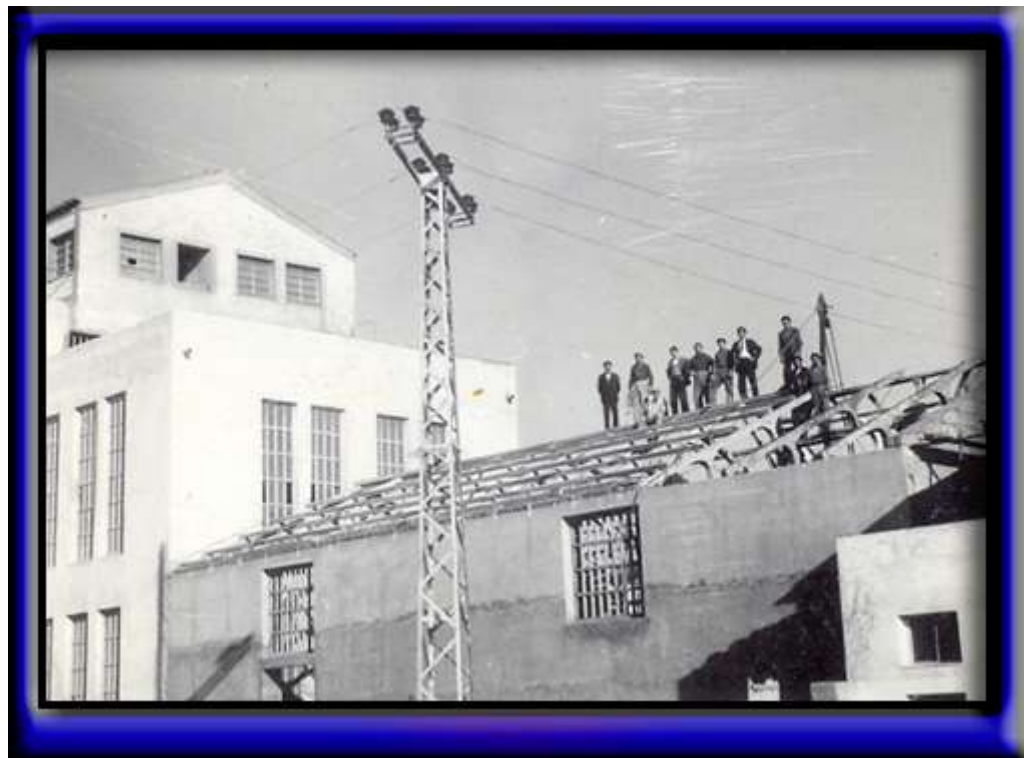
La fábrica del pienso en construcción
