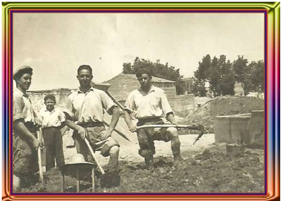
Quintin Sanabria preparando el barro con la paja para hacer ladrillos
