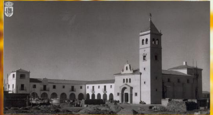
En esta foto, podemos ver el ayuntamiento y soportales terminados y la iglesia y torre casi terminada.
